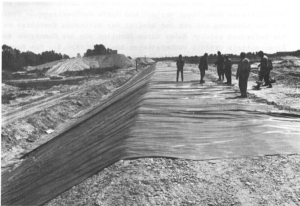
Abb. 9 : Einbau der PVC-Folien
