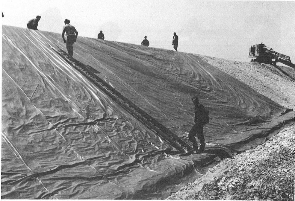
Abb. 8 : Verlegen von PVC-Folien auf der Dammböschung
