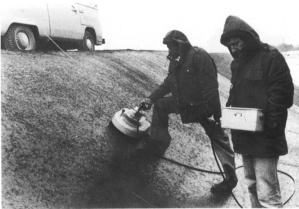
Abb. 7 : Fehlerstellenortung auf Asphaltbetonbelag
