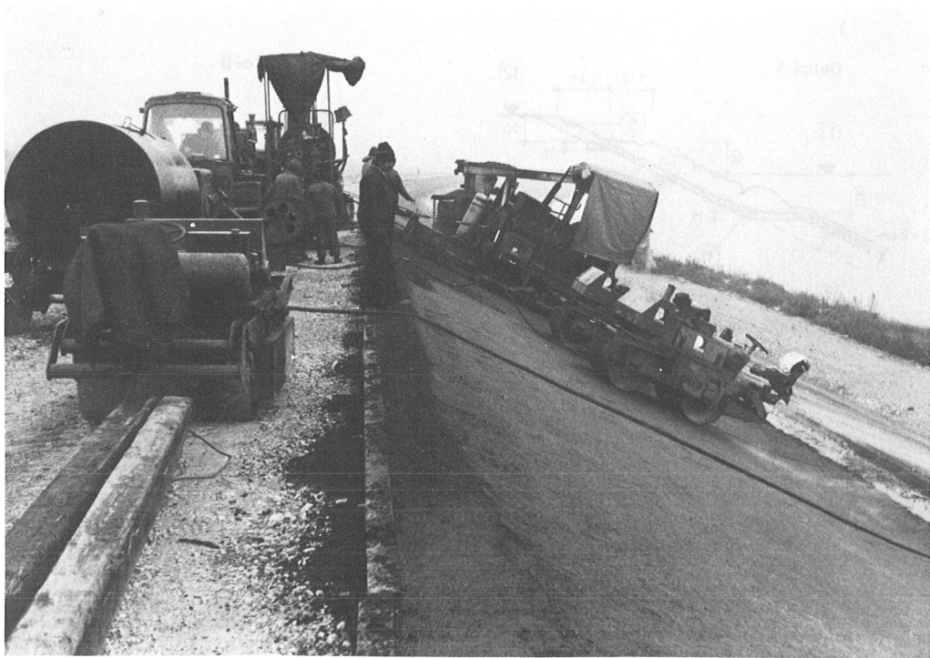
Abb. 2: Herstellung des Asphaltbeton-Belages
