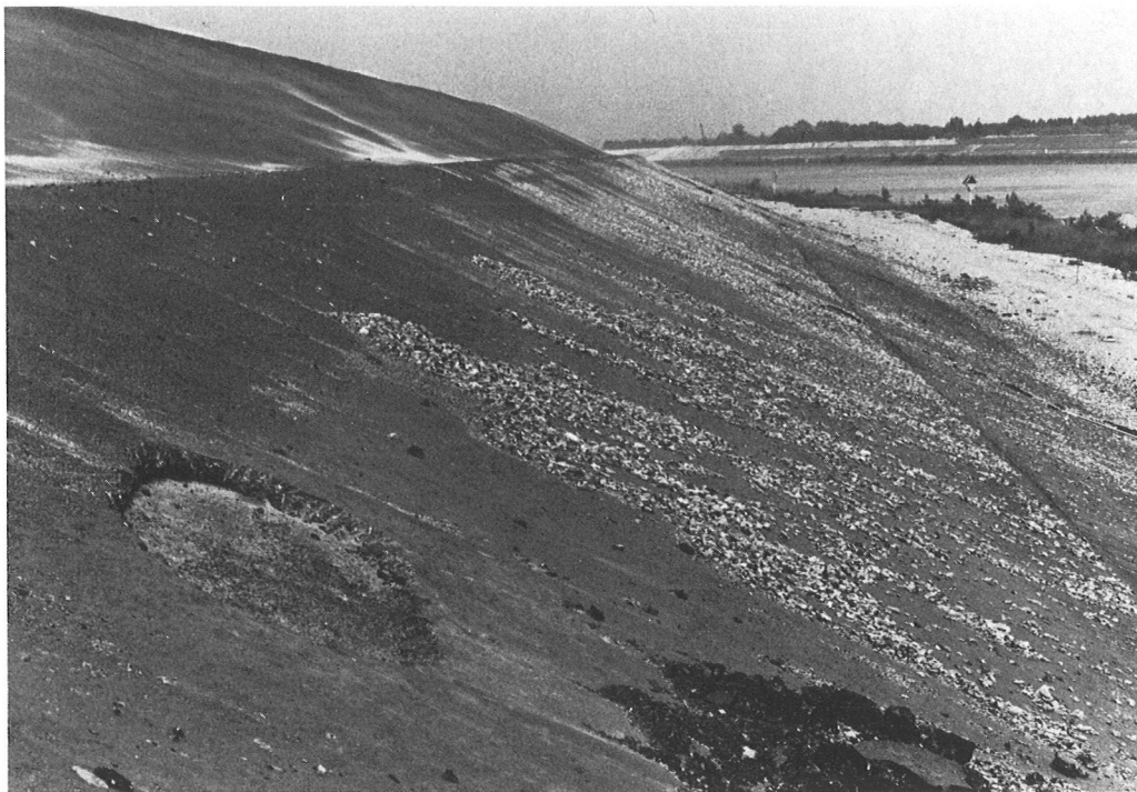
Abb. 8: Ausgehackte Schadensstelle
