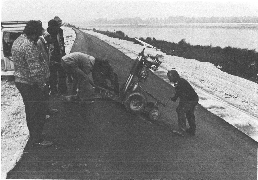
Abb. 9: Bohrkernentnahme eines Probestückes
