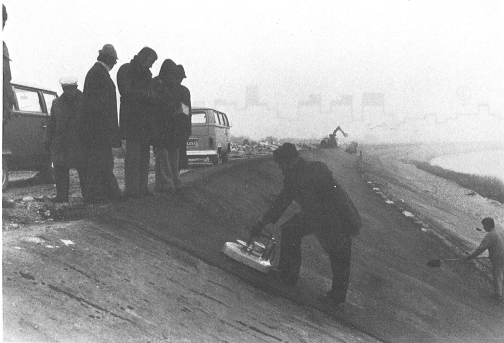
Abb. 4: "Fehlersuche" auf dem fertigen Belag
