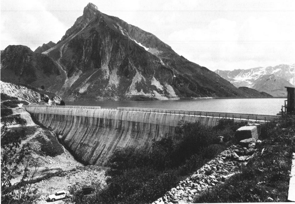
6b SPULLERSEE NORDSPERRE
