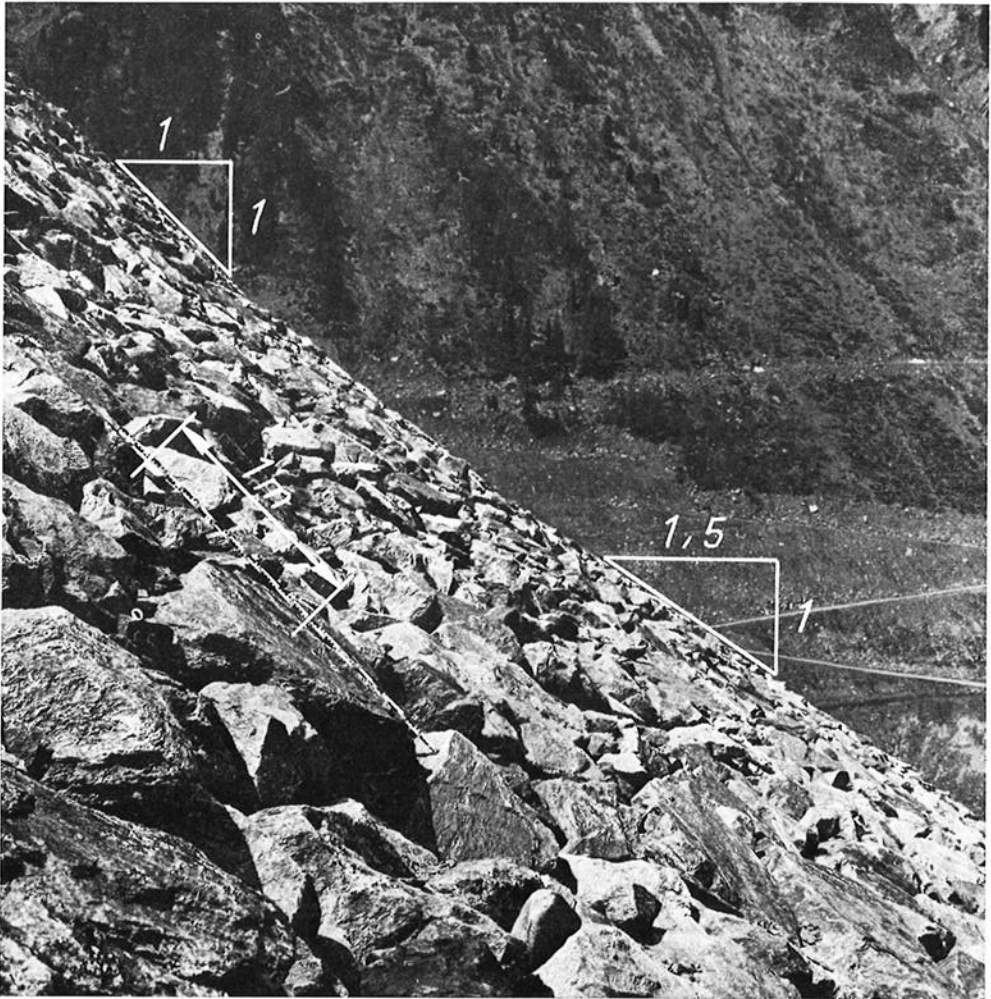
Abb. 10. Staudamm Gepatsch: Blockabdeckung
