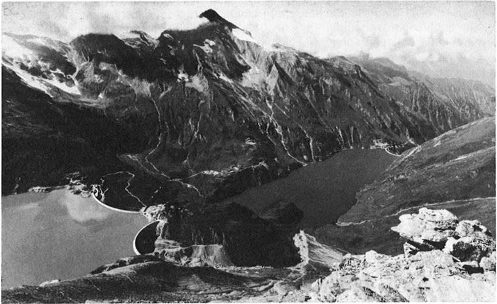
Abb. 1. Speicher Mooserboden und Wasserfallboden der Tauernkraftwerke AG, Salzburg. Speicher Mooserboden: Inbetriebnahme 1956, Stauziel 2036 m, Nutzinhalt 85,4 hm 3 . Speicher Wasserfallboden: Inbetriebnahme 1951, Stauziel 1672 m, Nutzinhalt 83,0 hm 3
