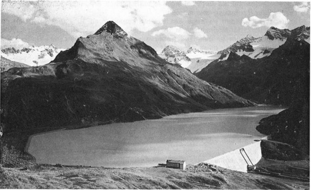
Abb. 4. Speicher Silvretta der Vorarlberger Illwerke AG, Bregenz. Inbetriebnahme 1950, Stauziel 2030 m, Nutzinhalt 38,6 hm 3
