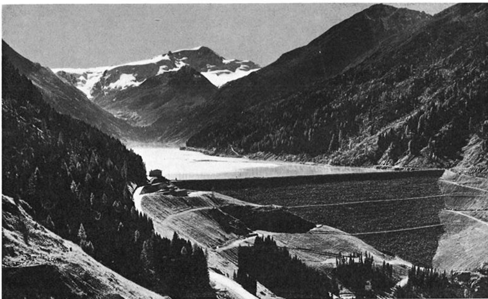
Abb. 2. Speicher Gepatsch der Tiroler Wasserkraftwerke AG, Innsbruck. Inbetriebnahme 1966, Stauziel 1767 m, Nutzinhalt 138,3 hm 3
