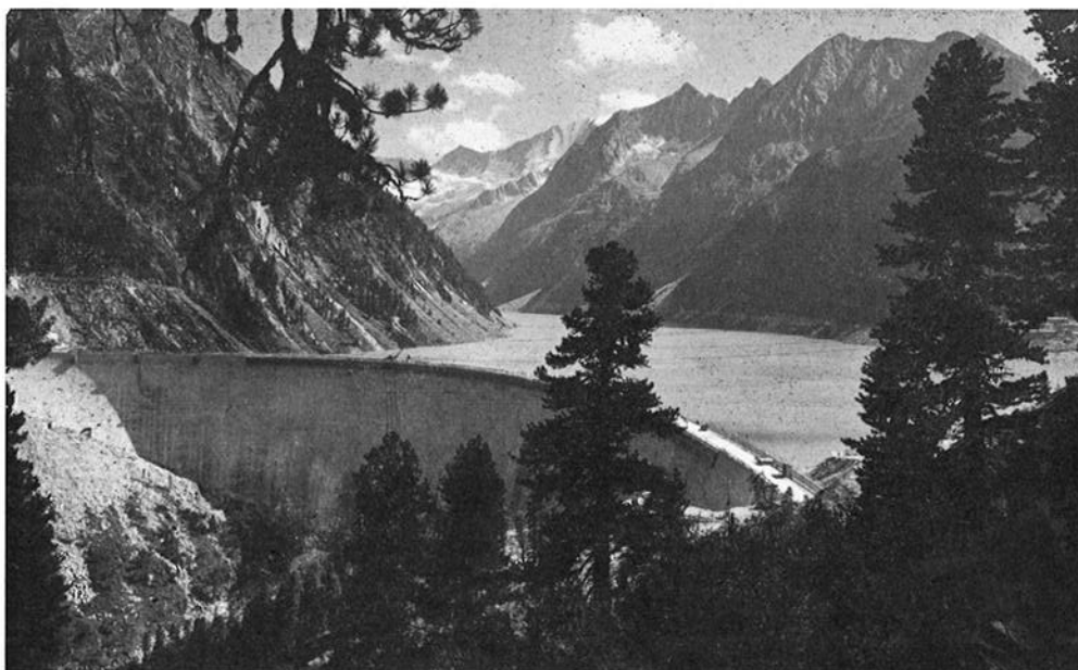
Abb. 3. Speicher Schlegeis der Tauernkraftwerke AG, Salzburg. Inbetriebnahme 1971, Stauziel 1782 m, Nutzinhalt 127, 4 hm 3
