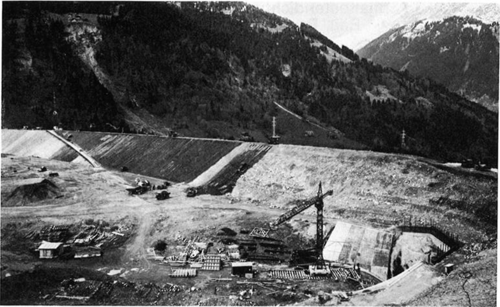
Abb. 2. Staubecken Latschau während der Bauausführung
