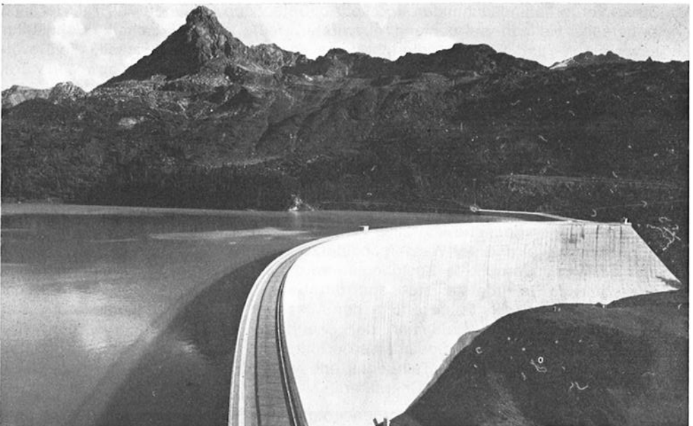
Abb. 5. Speicher Kops der Vorarlberger Illwerke AG, Bregenz. Inbetriebnahme 1967, Stauziel 1809 m, Nutzinhalt 43,5 hm 3
