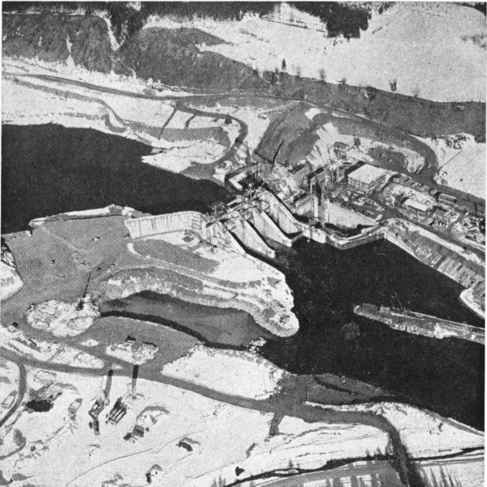
Abb. 19. Luftbild der Abriegelungsstelle nach der Umleitung
