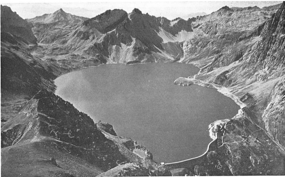
Abb. 6. Speicher Lünensee der Vorarlberger Illwerke AG, Bregenz. Inbetriebnahme 1959, Stauziel 1970 m, Nutzinhalt 78,3 hm 3
