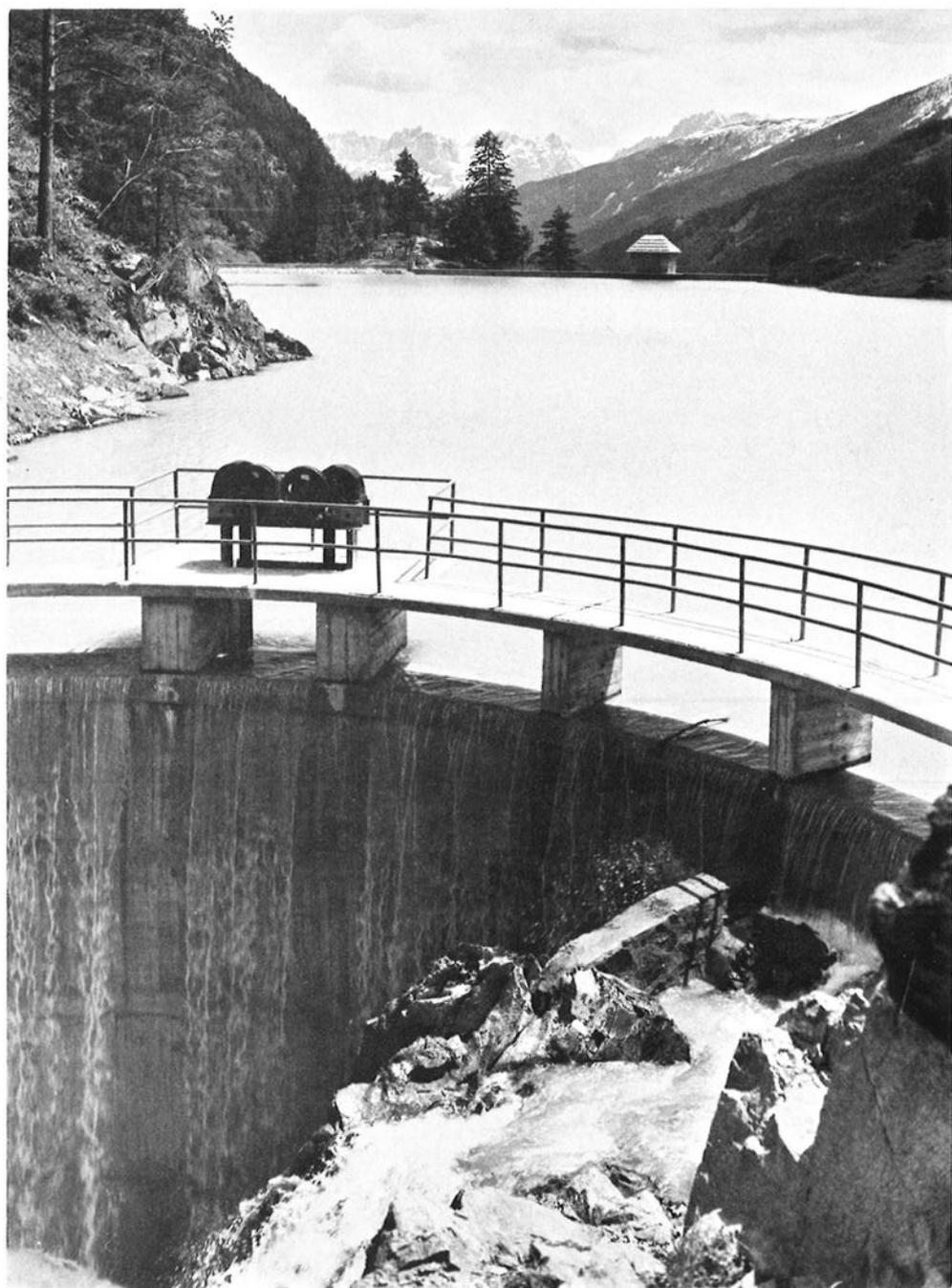
1. Das Wasserschloßbecken Obblaf des Kraftwerkes Kaiserbach (im Vordergrund die Entlastungsanlage)
