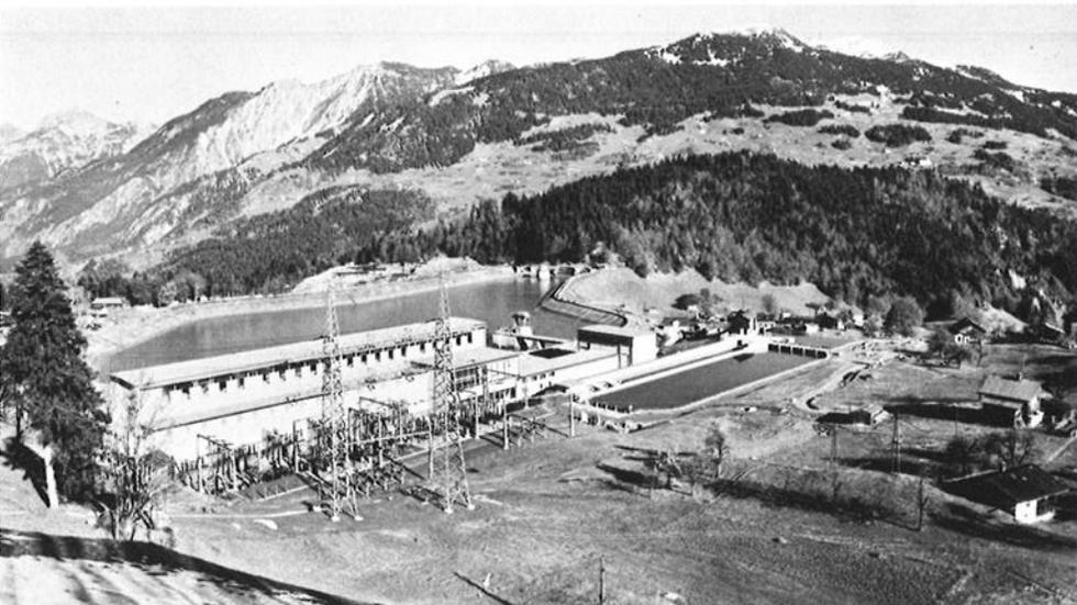
10. Der Kurzzeitspeicher Latschau des Kraftwerkes Rodund I und Gegenpumpspeicher für das Kraftwerk Lünsersee
