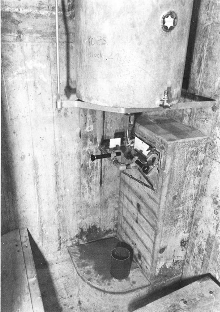
Abb. 7 Lotmeßstelle in der Mauer (mit eingesetztem Koordiskop)
